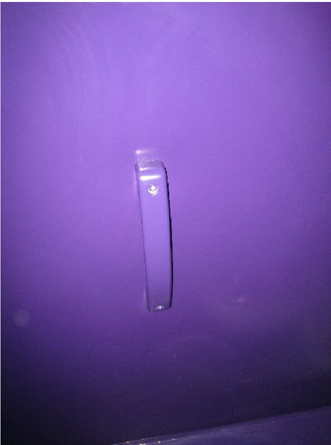
Bild 23 Haltegriff im Sanitärraum Farbgleich zur umgebenden Wand somit für Sehbehinderte schwer zu sehen
