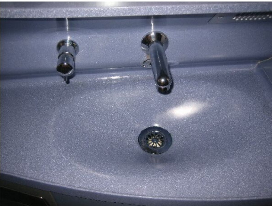
Bild 24 Waschbecken mit darüber angeordnetem Wasserhahn und Seifenspender
