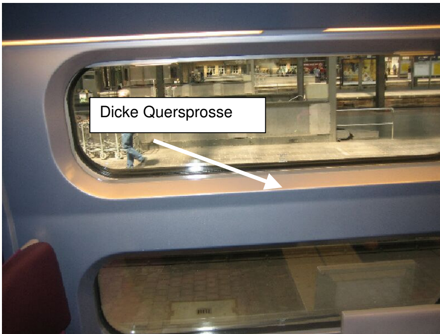
Bild 27 Dicke Quersprosse im Außenfenster stört Ausblick
