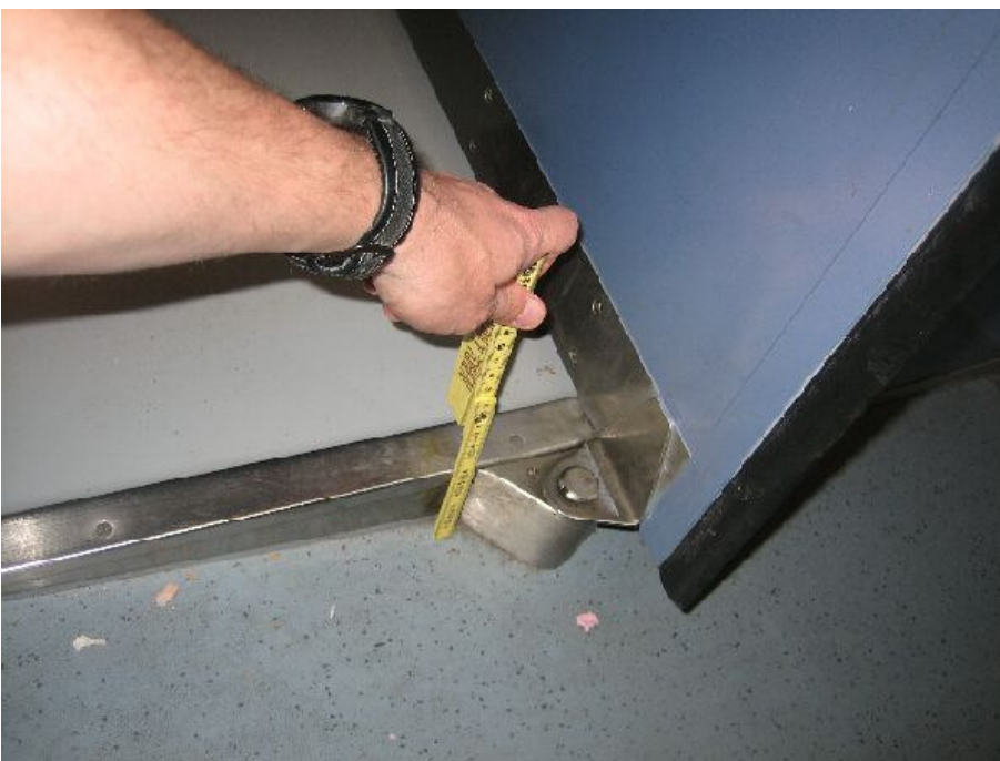
Bild 21 Schwellenhöhe beträgt bis zu 5 cm
