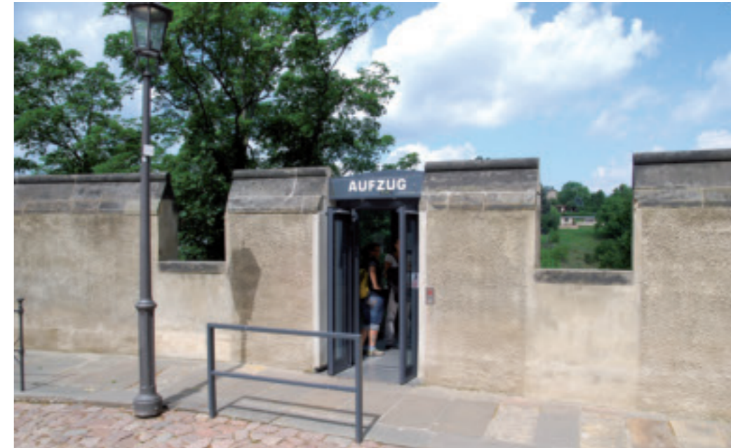
Domberg Meißen, rückseitige Erschließung mit Schrägaufzug vom Parkplatz aus. Bergstation (Foto: Thomas Will)
