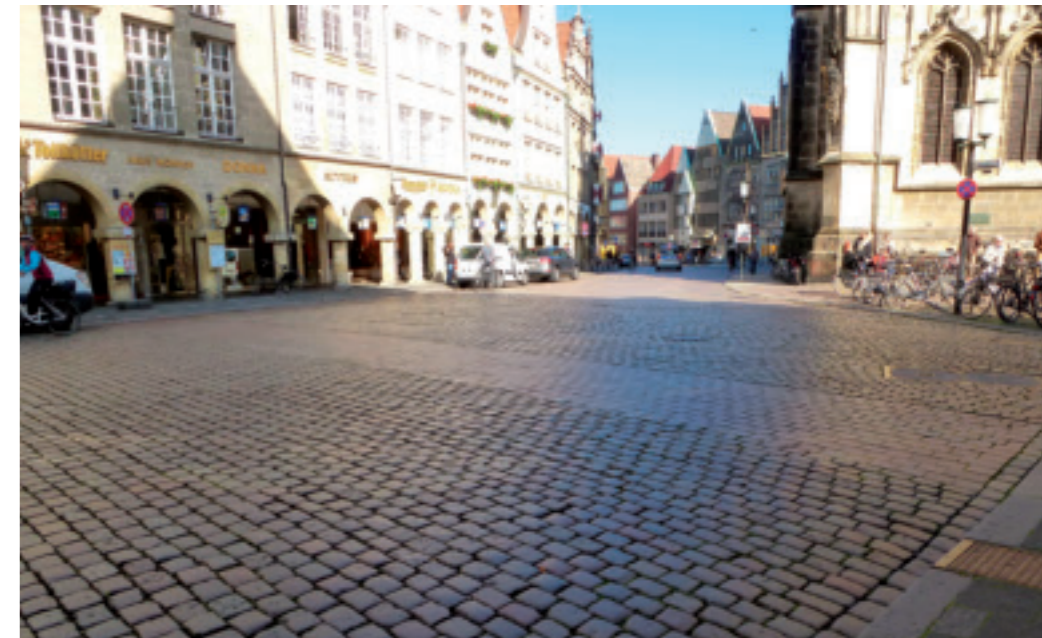
Prinzipalmarkt in Münster mit glattem Pflasterverbund an den Hauptquerungen (Foto: Michael Kappel)
