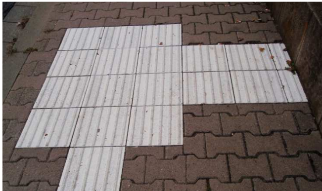
Bild: Taktile Auffindestreifen mit Einstiegsfeld und Leitlinie an einer Haltestelle
