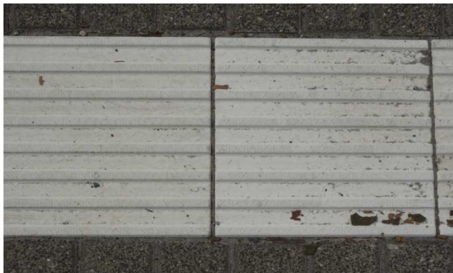
Bild: Taktile Leitlinie in Rippenplatte
