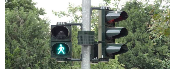
Bild: Ampel mit Blindenton
