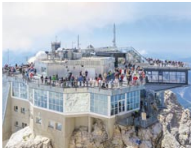
Foto: Die Bergstation der Seilbahn Zugspitze gilt als technische Meisterleistung. Die Seilbahn überwindet rund 2.000 Höhenmeter auf der über 4.500 Meter langen Strecke.
