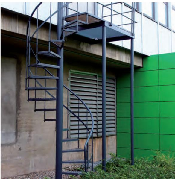
**Abbildung 44:** Negativbeispiel – Perspektive durch Gitterroststufen
