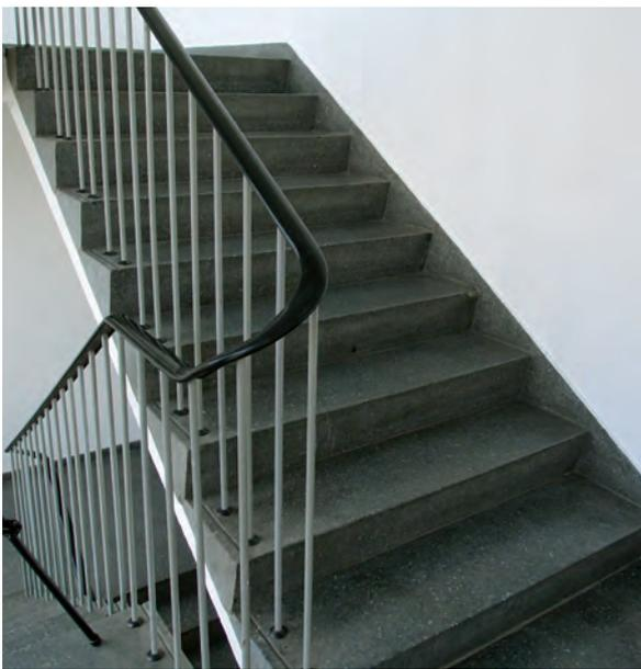
**Abbildung 40:** Positivbeispiel – Stufenmarkierung auf Linoleum
