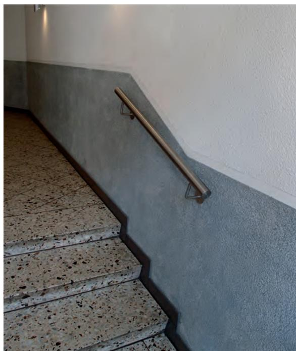
Die Sicherheitsmarkierung auf einzelnen Stufen ist dennoch nötig. Bei Fest- und Fahrtreppen sind nach DIN 32975 sowohl Trittstufen als auch Stirnseiten über die volle Breite zu markieren. Für die Trittstufe ist ein von der Stufenvorderkante gemessener 4 bis 5 cm breiter Streifen anzubringen. Die Stirnseite, auch Setzstufe genannt, muss einen 1 bis 2 cm breiten Streifen, gemessen von der Stufenkante, aufweisen. Der Handlauf der Treppe hat auch zu geringe Kontraste zur Wand.
