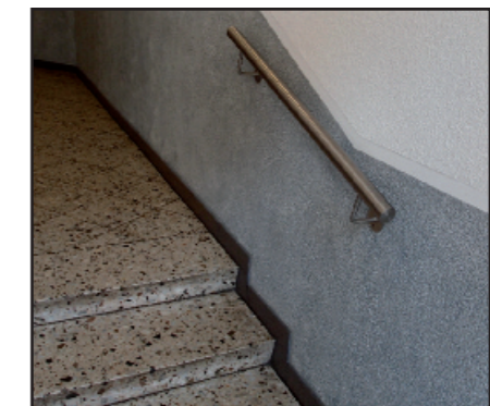
Abbildung 38: Negativbeispiel – fehlende Stufenmarkierung und kontrastarmer Handlauf
